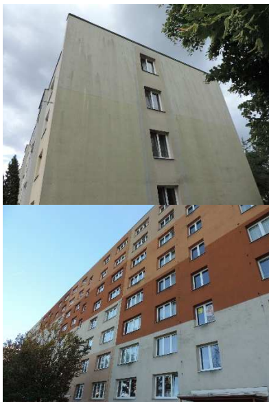
Obr. 1 – 3: Vzorová foto objektů napadených mikroorganismy v řádu nad cca 25 % plochy pláště fasády.
