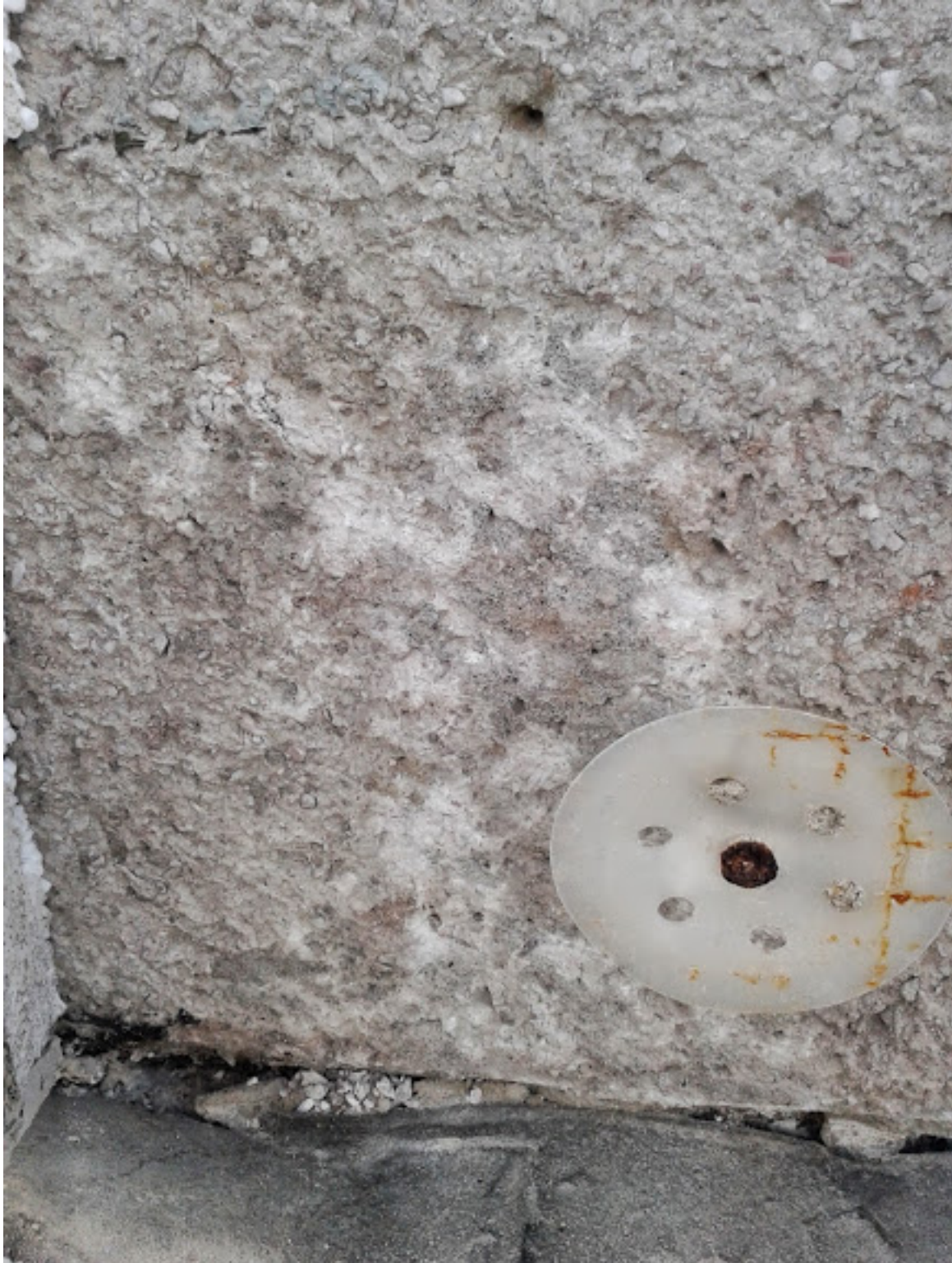
Řez souvrstvím fasády s napojením na stěnu. Vše v dobrém stavu.
